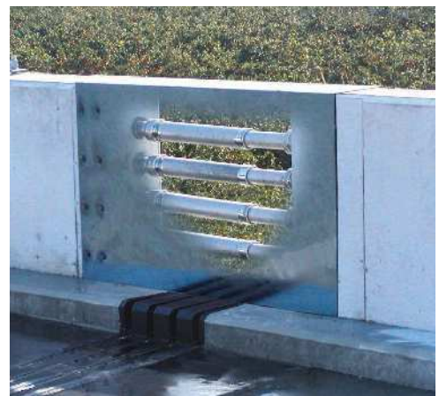
現場施工透視写真
