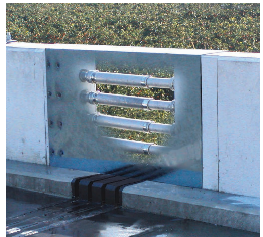
現場施工透視写真
