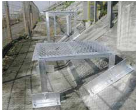
配電盤点検足場台
